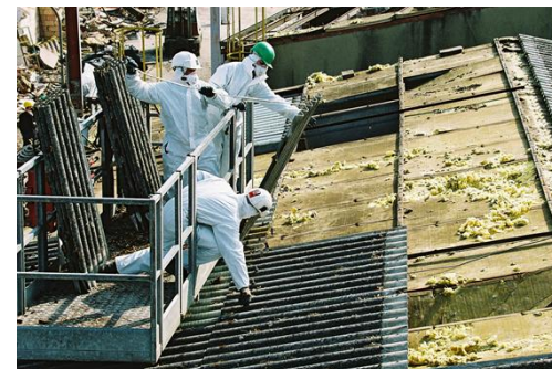
Enlèvement des plaques de couverture en fibro-amiante avant démolition
